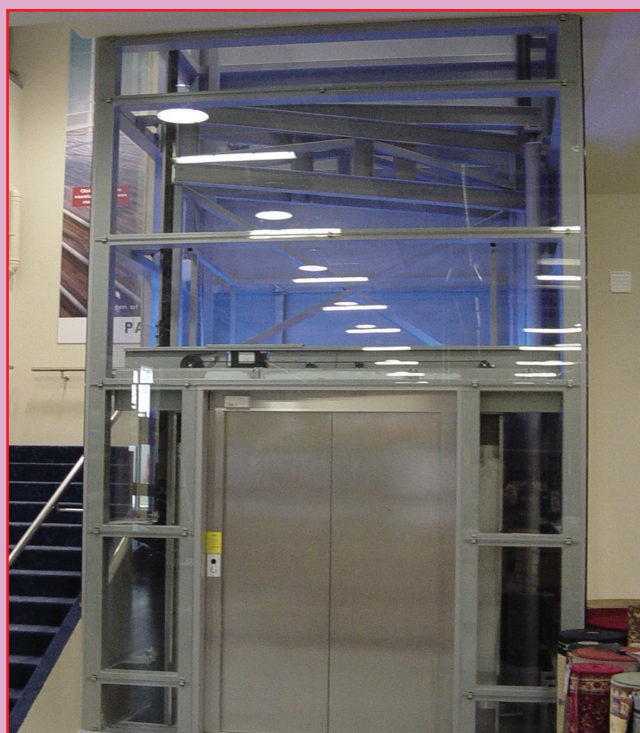
Osebno dvigalo nosilnosti 1600 kg oz. 21 oseb v kombiniranem voznem jaku, cilinder ob strani, 2x diagonalno
